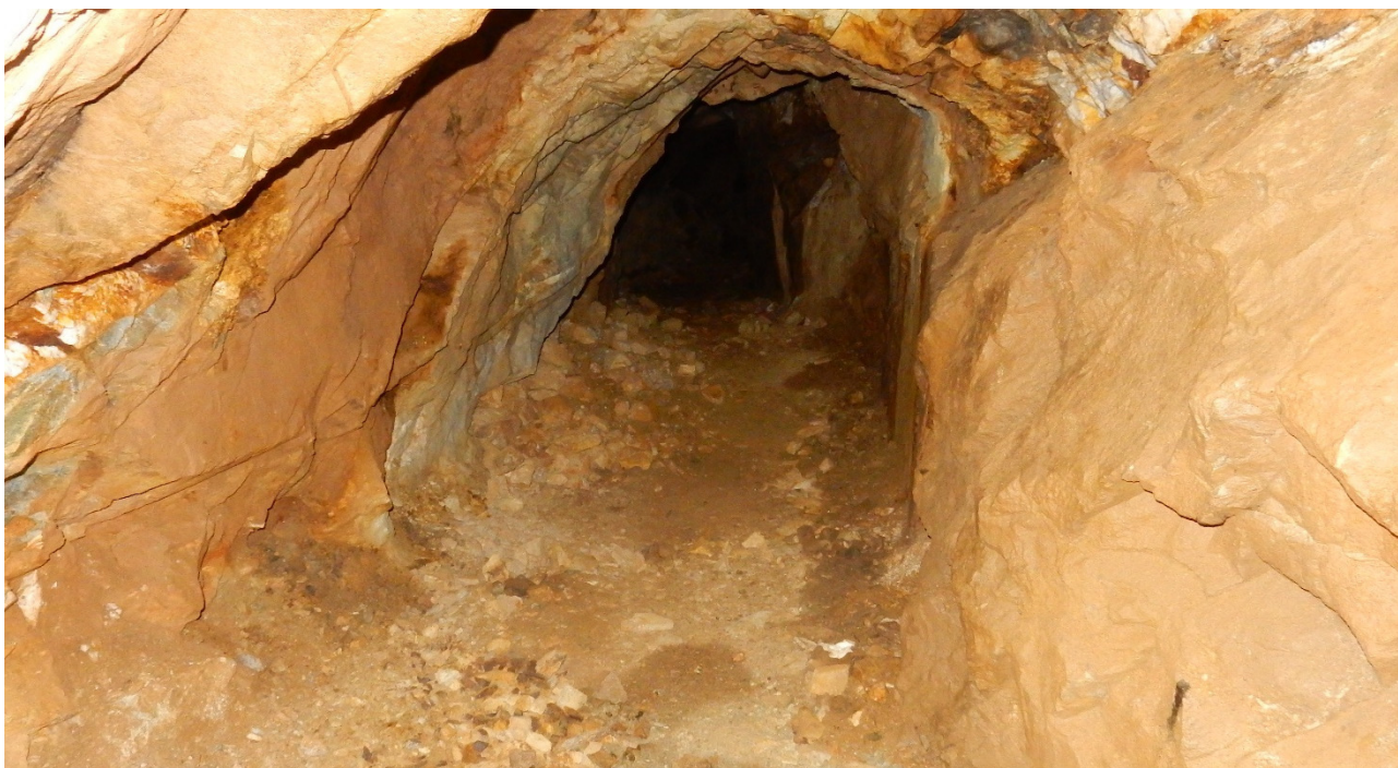
Figura 18: primo tratto di galleria lungo il livello 6 da pulire (spietramento più idropulizia a parete).
