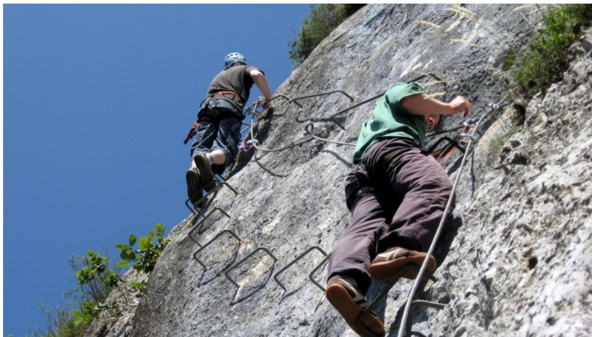
Figura 12: esempio di via ferrata con identificazione di staffe, fune e ancoraggi.
