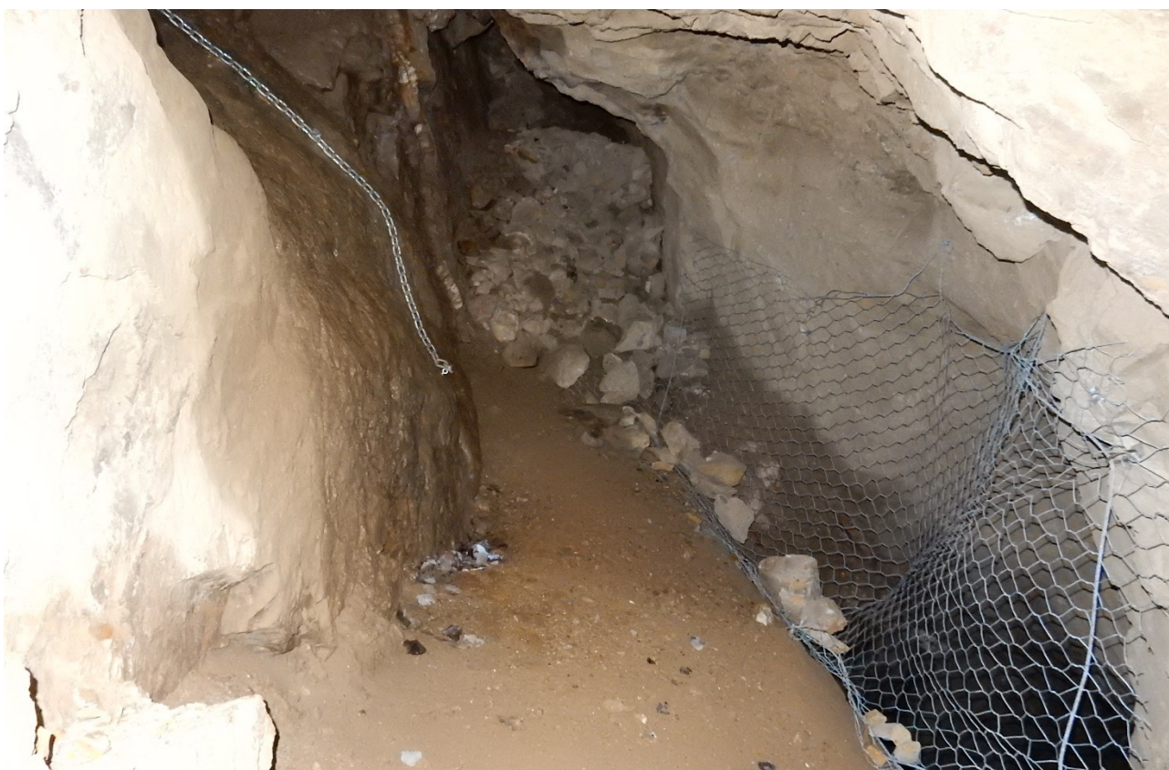
Figura 19: a sinistra il punto dove installare la catena di chiusura in acciaio zincato, a destra la rete romboidale da sostituire con nuova chiusura in tondi di acciaio saldati e inghisati nella roccia, al centro il tratto di galleria al livello 6 da liberare dai detriti di roccia.
