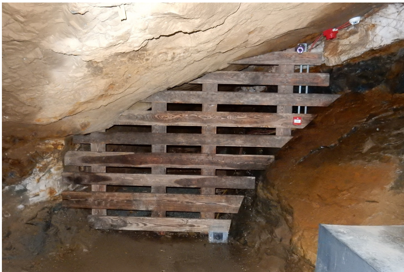
Figura 20: chiusura in assi di legno da sostituire con nuova chiusura in tondi di acciaio saldati e inghisati nella roccia con maglia quadrata.
